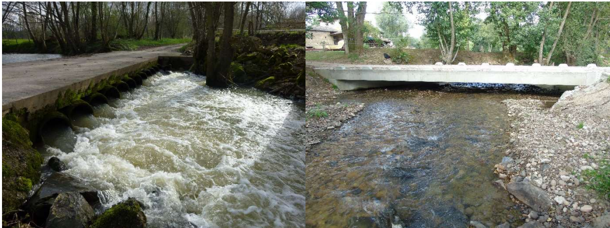
Photos avant et après travaux
