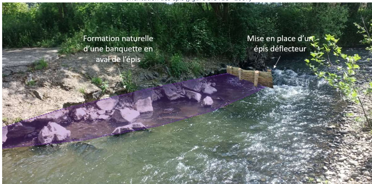
Illustration schématique de différents effets produits sur la diversification des substrats ou des hauteurs d'eau liées à l'orientation des épis (figure BIOTEC - 2007)
