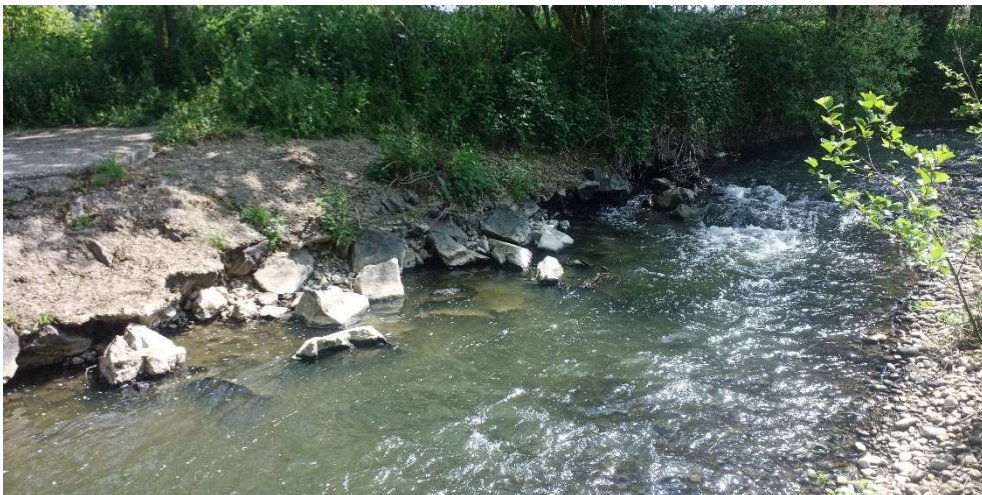
Erosion sous berge, rive droite en amont du gué
